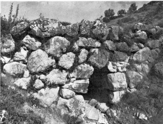
Abb. 10. Mykenische Brücke am Wege nach Epidauros
