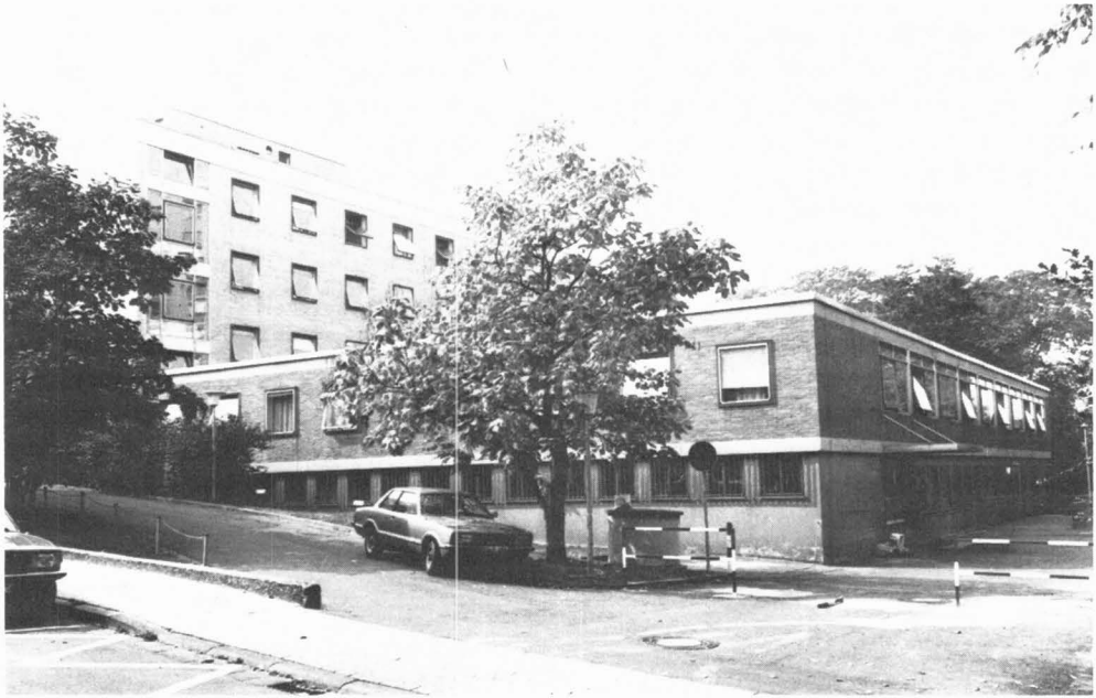
Abb. 17.2: Der Poliklinikbau mit den Ambulanzkabinen (1982)
