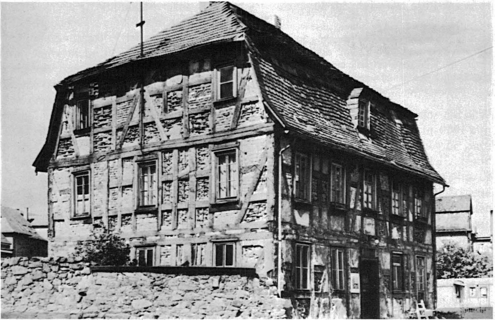
Abb. 6: Das alte Bürgerhospital und spätere Pfründnerheim.
