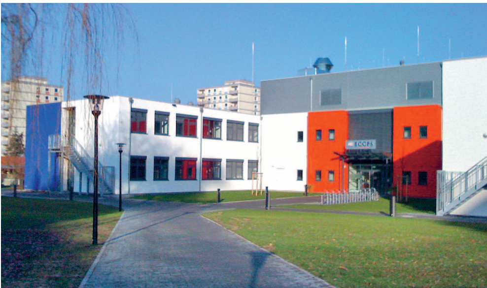
Abb. 1: ECCPS-Neubau im Aulweg 130; die Grundsteinlegung erfolgte im Juni, die Einweihung im Dezember 2008
