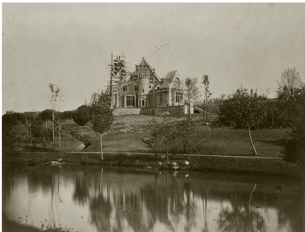
Abb. 6: Rauschholzhausen, 1874. Auf diesem Foto aus der Bauphase ist die fertig gestellte Geländemodellierung zwischen Schloss und Burgteich zu sehen. Die Baumschulgehölze und die aus dem Wald geholten Bäume lassen sich aufgrund der Kronenentwicklung gut unterscheiden (© Bildarchiv Foto Marburg/Dieter Schumacher).
