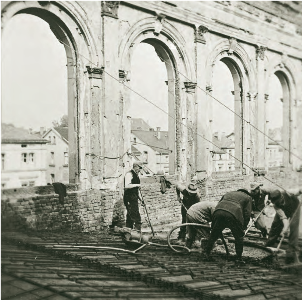
Reparaturen am zerstörten Hauptgebäude der Universität nach 1945.
