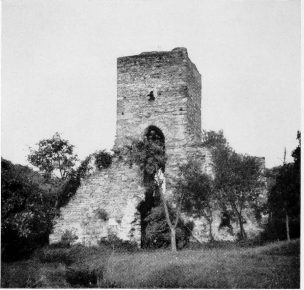
Abb. 3. Landsteiner Kirche bei Altweilnau.
